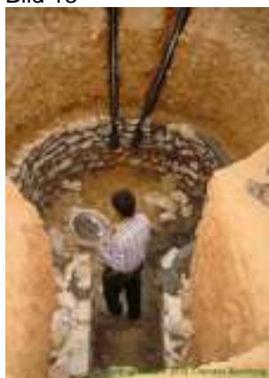
Aufmauern des zylinderförmigen Unterbaus der Gärgrube.
