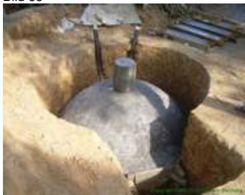
Die fertige Biogasanlage in offener Baugrube.
