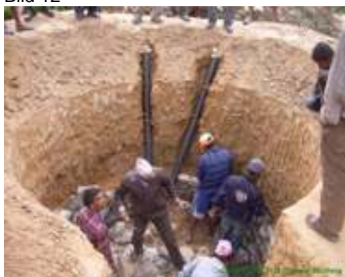
Einbau der Kunststoffrohre.
