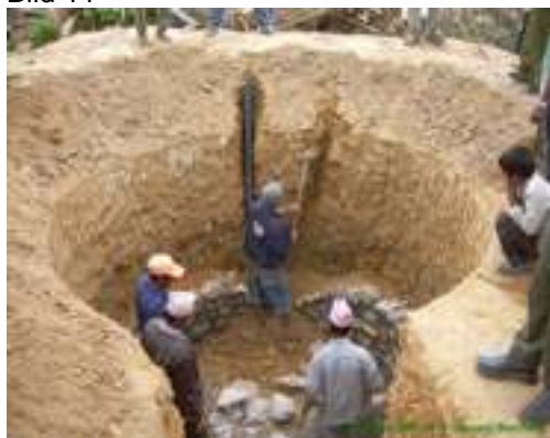
Verlegung der Kunststoffrohre.
