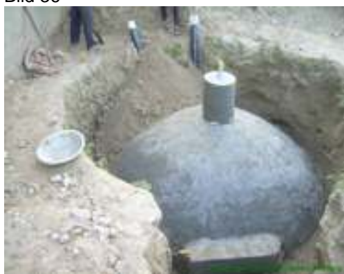
Nach dem Aushärten des Betons beginnt das Bedecken des Reaktors mit Erdaushub.
