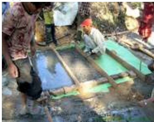
Fertigteile werden hergestellt.
