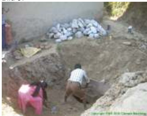
Bedecken mit Erde. Der Bereich des Überlaufs wird freigehalten.
